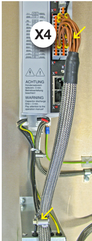
Bild 4.12 Musteraufbau - Detail 4: Steuerleitungen C2 bis C4
