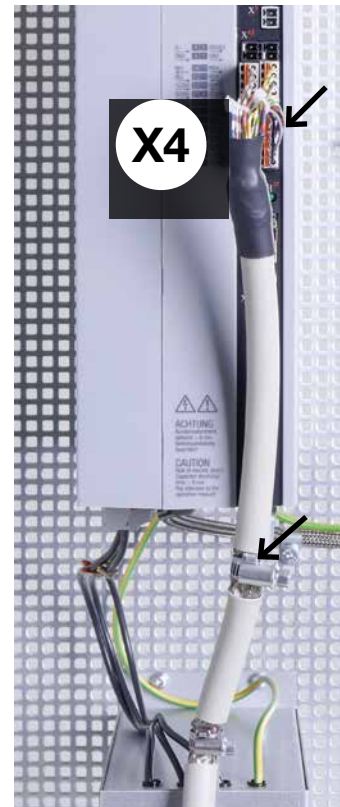
Bild 4.13 Musteraufbau - Detail 4: Steuerleitungen C5
